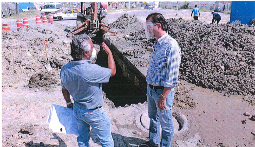
El alcalde Everardo Benavides Villarreal recorrió los sectores donde se está trabajando, para supervisar el avance de las obras.
